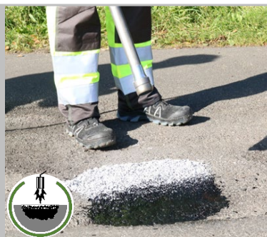
חמם היטב את ה- ChipFill™ עד לקבלת מרקם אחיד וחלק על פני כל השטח
