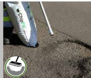
נקה היטב את שטח הבור מליכלוך וחמם היטב את הבור וסביבתו עם מבער גז
