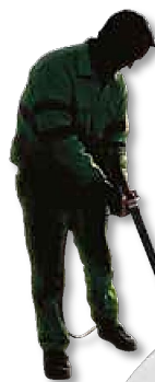
התקנת יריעות PREMARK® קלה, פשוטה ומהירה. דרוש צוות של איש אחד, מטאטא ומבער גד.
